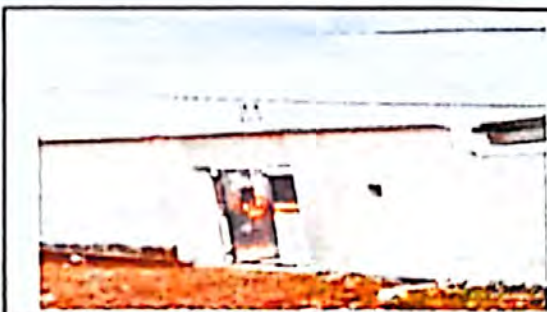
Foto 6: MURO Y REPELLO CONCLUIDO
