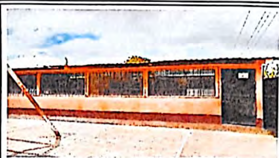
Foto 2: antes del cambio de techo
