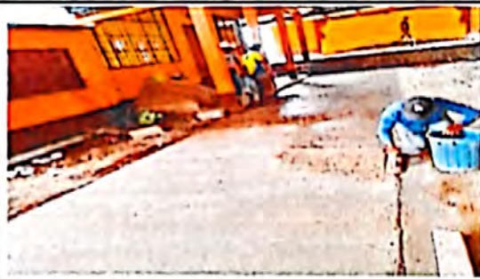
Foto 4: DURANTE LA EJECUCION DE LA OBRA
