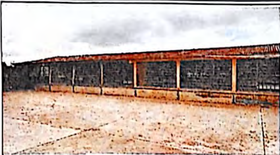
Foto 1: ANTES DE MANTENIMIENTO
