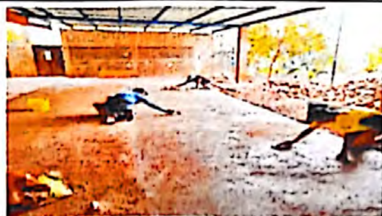
Foto 3: DURANTE LA EJECUCION DE LA OBRA
