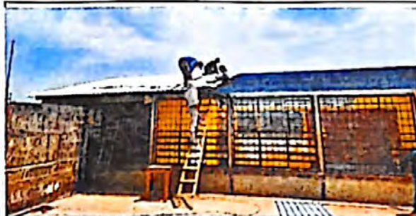
Foto 1: DURANTE EL CAMBIO DE TECHO
