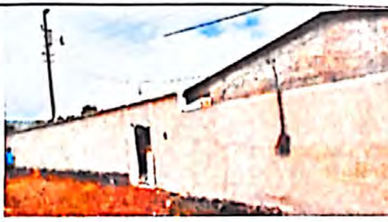
Foto 5: MURO Y REPELLO CONCLUIDO
