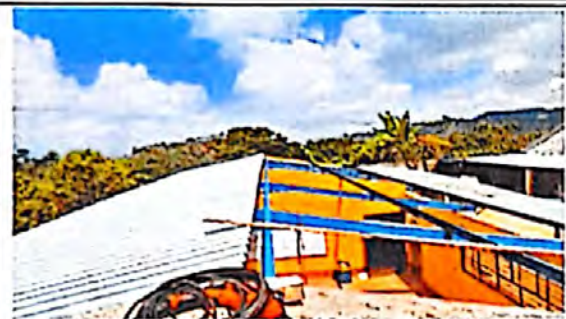
Foto 2: DURANTE EL CAMBIO DE TECHO
